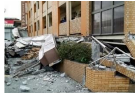
1階店舗がつぶれたビル(熊本市内)
