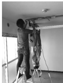
仮設住宅でクーラーの取り付け作業
