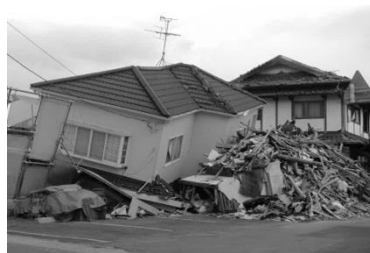
解体されないままの倒壊家屋
