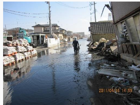
復旧作業をしたくても、潮が満ちると浸水してしまう
