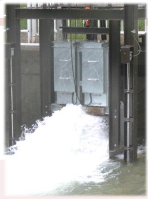
東北おひさま発電 野川3号幹線小水力発電所
