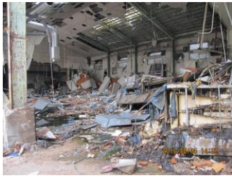
震災直後の高橋徳治商店の工場
