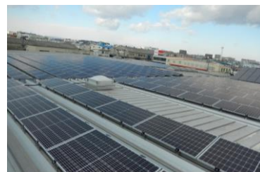
パネルが敷き詰められた屋上
