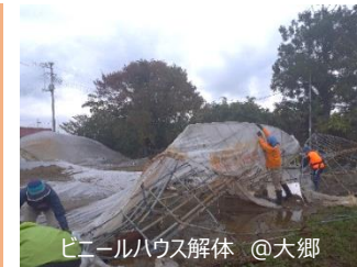
ビニールハウス解体 @大郷
