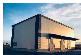
新築されたライスセンター
