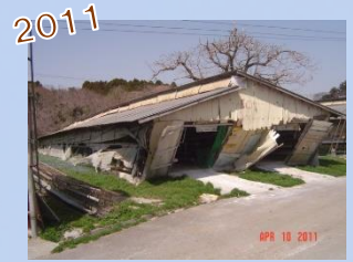
半壊した鹿島台の鶏舎「全壊」よりも補助がなく費用面で苦しんだ
