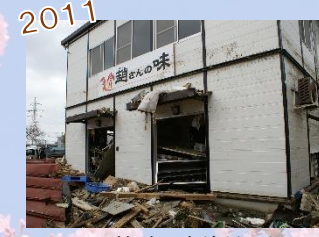
お披露目直前だった新築の工場が被災
