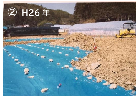
田んぼの上にブルーシートを敷き土をかけて造成、さらに覆いをかけて木漏れ日も再現した(右下)。
