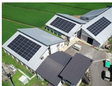
空撮による農場全景
